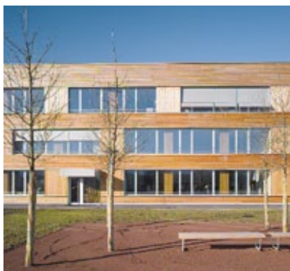
Premier bâtiment passif certifié GI de Suisse.
