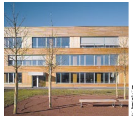
Erstes mit dem GI-Label zertifiziertes Passivhaus in der Schweiz. Schulhaus «Eichmatt» der Gemeinden Hünenberg und Cham.
